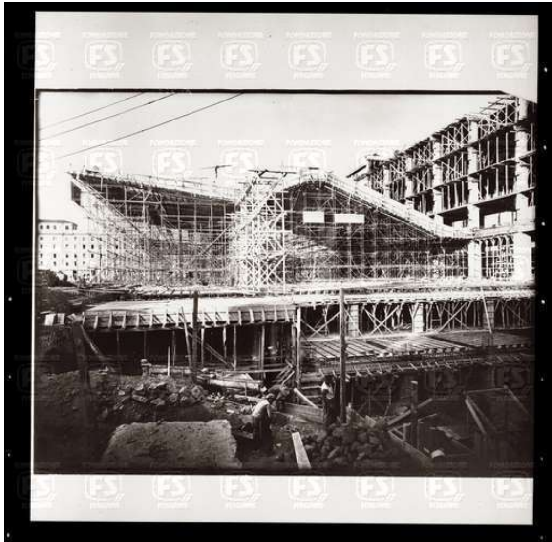
La nuova testata della Stazione Termini, cantiere di costruzione, 1948-1950
