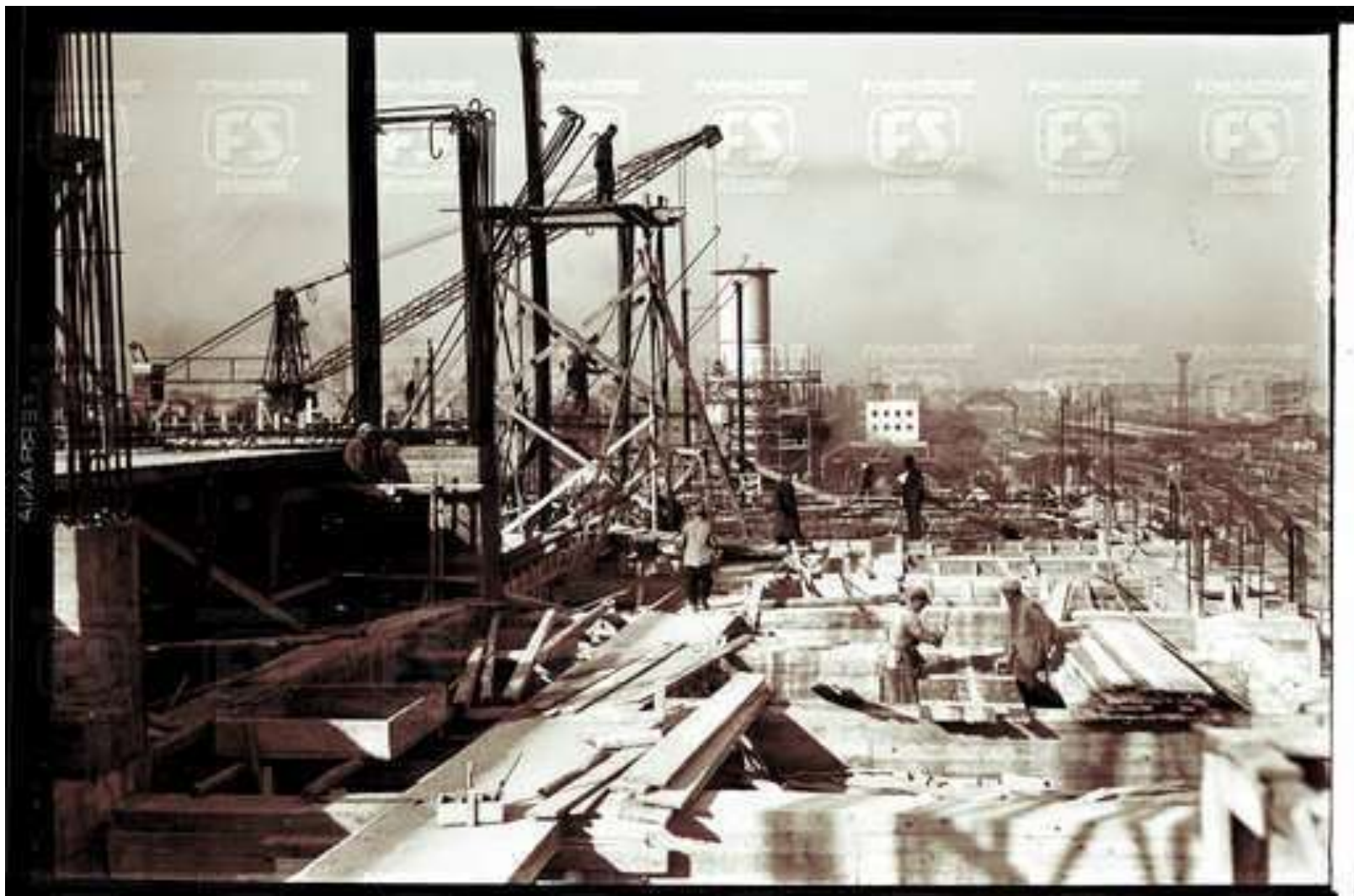
La realizzazione della Stazione su progetto di Angiolo Mazzoni, 1939-1943
