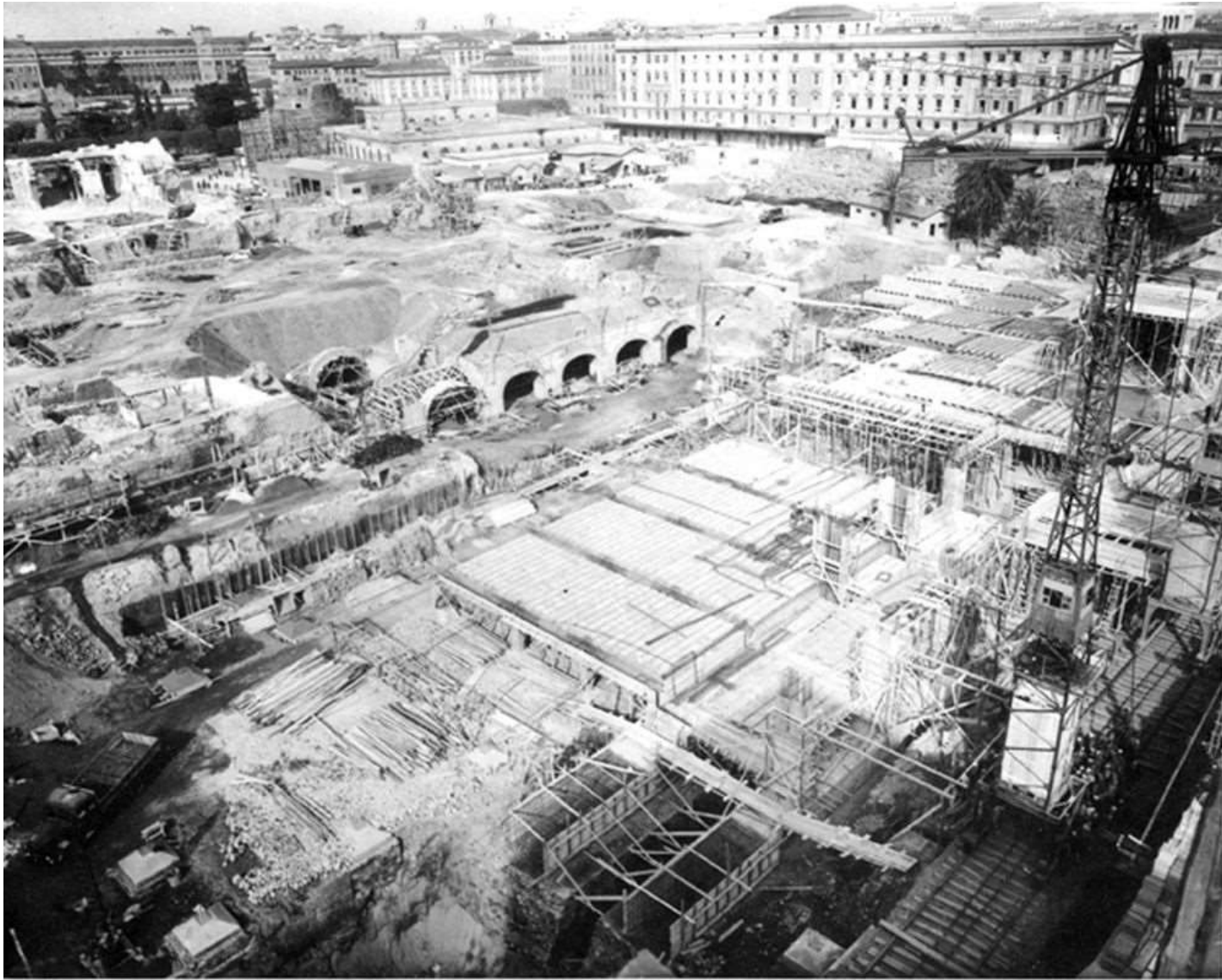
Piazza dei Cinquecento, scavo per la realizzazione della testata della nuova stazione, 1950 circa \
