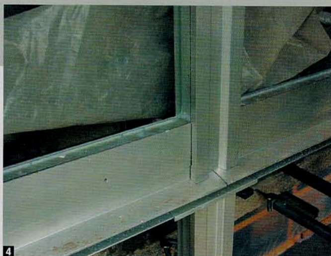
Figura 3 – I profilati in alluminio anodizzato, dopo il restauro, ripresi dall'interno dell'edificio; il sigillante, steso lungo il profilo degli elementi durante il rimontaggio, è di nuova fattura.
