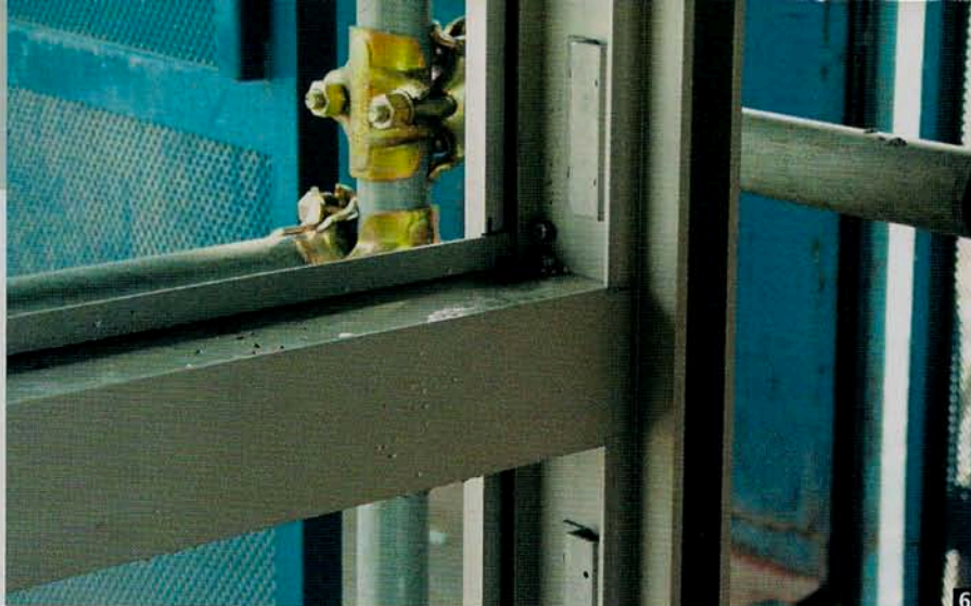
Figura 5 – La cerniera di un'anta apribile rimontata in sede, con le ferramenta originali, dopo il trattamento in laboratorio. Figura 6 – Un montante restaurato e rimontato cui è stato aggiunto il fermavetro necessario a trattenere le nuove lastre, più spesse delle preesistenti.
