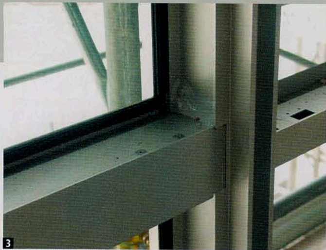
Figura 3 – I profilati in alluminio anodizzato, dopo il restauro, ripresi dall'interno dell'edificio; il sigillante, steso lungo il profilo degli elementi durante il rimontaggio, è di nuova fattura.
