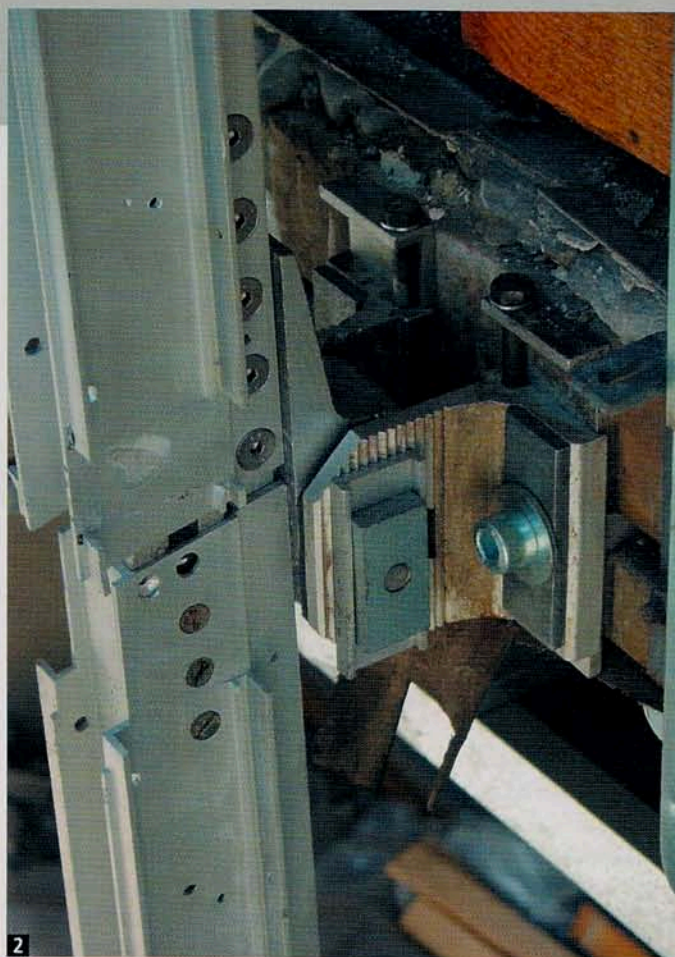
Figura 2 Dettaglio dei pannelli; il giunto di ancoraggio, fra i montanti della facciata continua e la soletta in cemento armato del solaio, rimontato dopo il trattamento di rianodizzazione e restauro.
