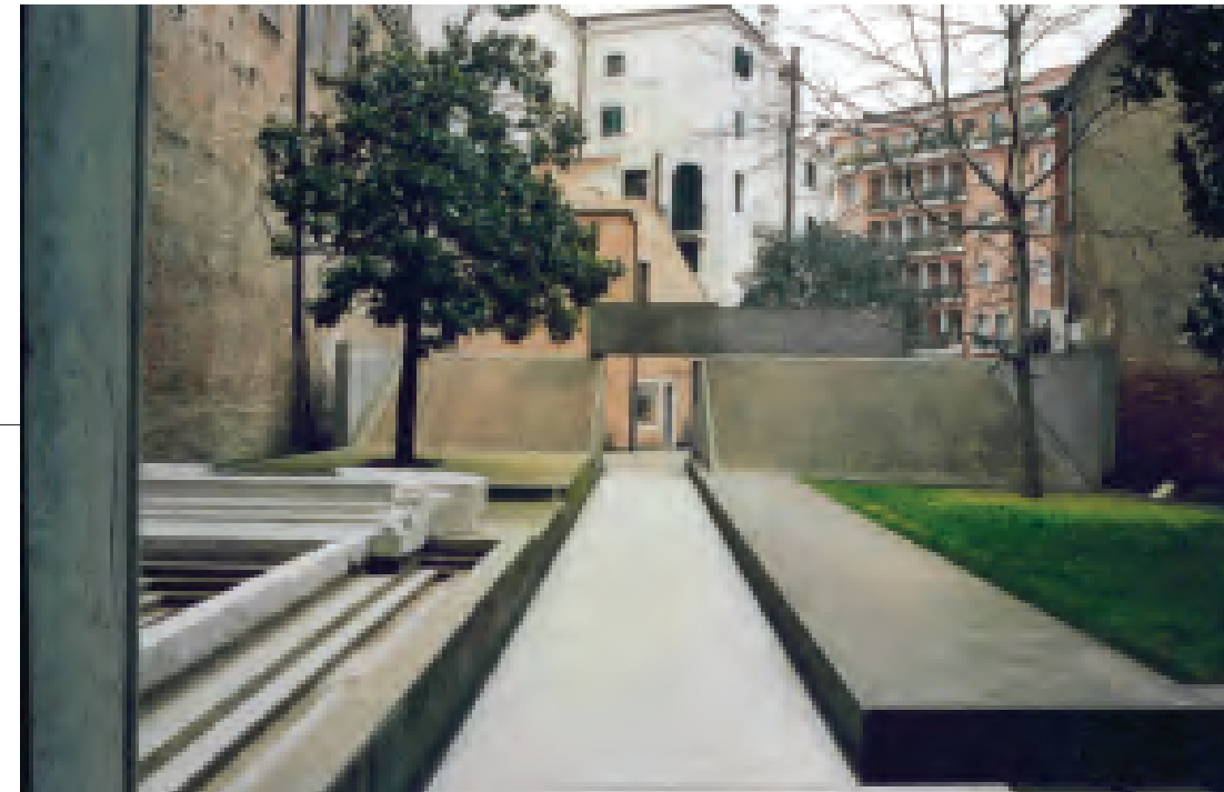
Fig. 10 - Venezia, ingresso all'ex convento di S. Nicola dei Tolentini, attuale Istituto Universitario di Architettura di Venezia (esecuzione 'differita' di S. Los su progetto di C. Scarpa, 1985). Delle tre fasi progettuali disegnate dall'autore, per costruire l'opera dopo la sua morte si è scelta la seconda versione, già approvata dall'autorità comunale poiché poneva all'operazione minori impedimenti d'ordine burocratico e amministrativo. Eppure la terza versione, schizzata da Scarpa poco prima di morire, mostrava un'ulteriore elaborazione, in specie per il muro a sinistra dell'ingresso, piegato più volte quasi a voler proseguire in verticale il gioco di rimandi spaziali di questo piccolo ambito rimasto evidentemente irrisolta. L'opera, pertanto, non possiede la complessità e il fascino delle opere del Maestro, che deriva dall'incessante attività progettuale proseguita ben oltre la stesura dei grafici, fino all'esecuzione del dettaglio più minuto (foto Salvo 2004).
