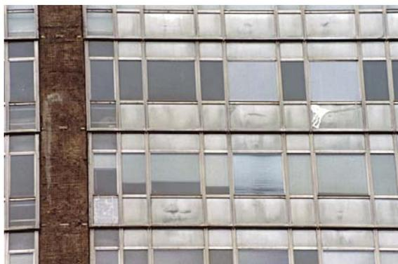
Particolare della facciata del grattacielo Pirelli verso Piazza Duca d'Aosta; è evidente il degrado dei pannelli curtain wall e le lacune nel rivestimento delle parti in cemento armato con mosaico in tessere di ceramica
