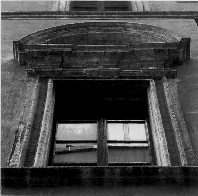
Fig. 15. Dettaglio di una cornice in cotto del prospetto del palazzo verso via del Forte; il materiale fu lavorato in opera e poi rivestito in stucco al fine di ottenere modanature del tutto somiglianti a quelle in pietra.
