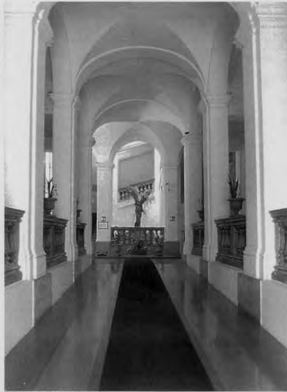
Figg. 24, 25. La galleria d'ingresso al palazzo ai primi del Novecento e nel suo stato attuale. Si noti come la geometria dell'intradosso delle volte sia mutata, forse in occasione dell'ultimo intervento di consolidamento strutturale.
