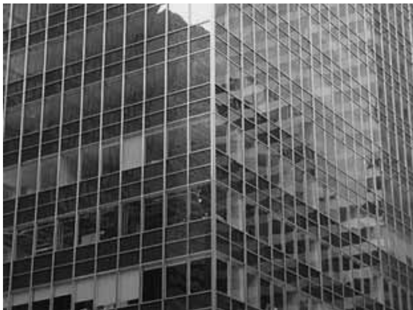
Lever House, New York; dettaglio delle facciate curtain wall dopo il ripristino.
