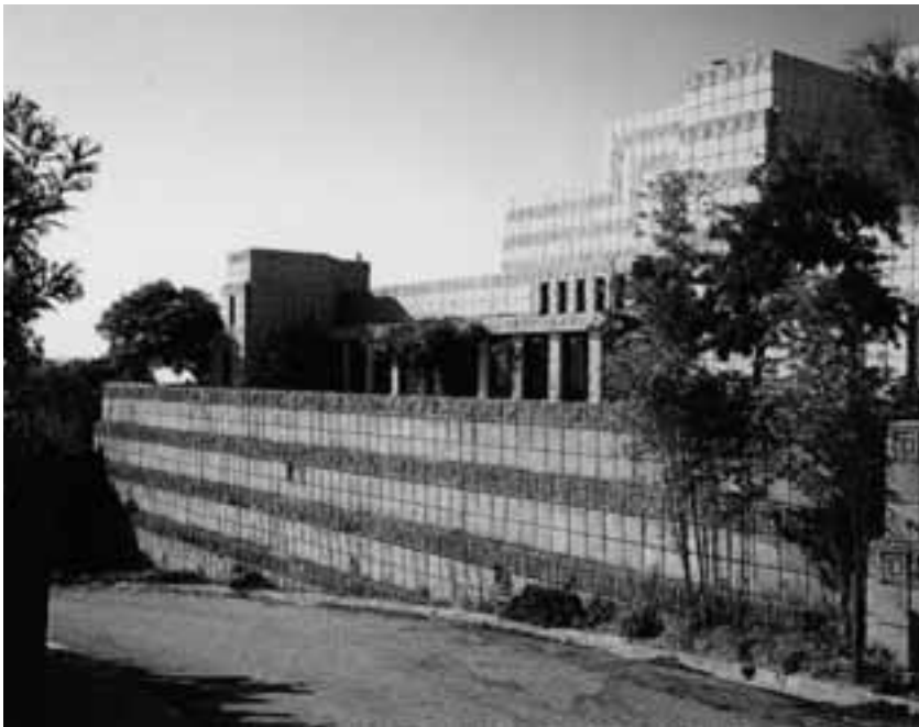
Frank Lloyd Wright, Casa Ennis Brown, Los Angeles; l'effettivo stato di degrado in cui oggi si trova l'opera
