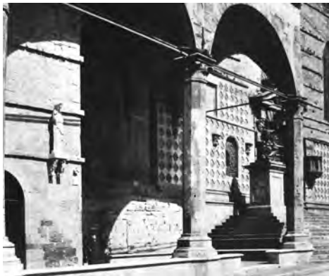
Perugia, Loggia di Braccio Fortebraccio nella "piazza grande" dopo la sistemazione del 1928 (da ANGELINI 1980).
