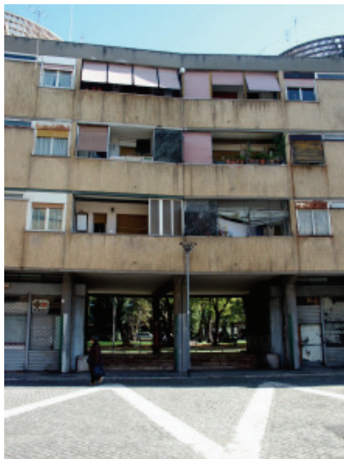
Figura 10: Roma, Vila Olímpica. Formas de degradação e de modificação Foto: Simona Salvo, 2010
