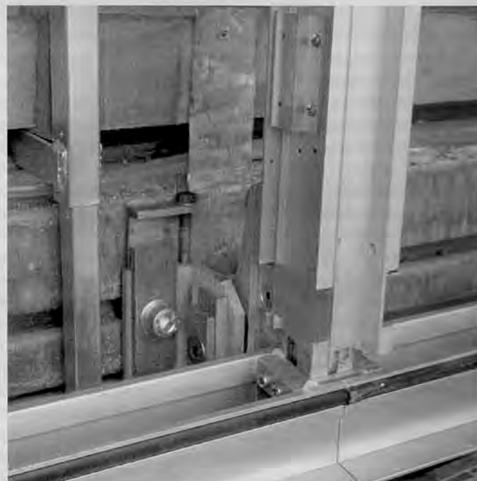
Fig. 8 - Dettaglio di un nodo montante/traverso in corrispondenza dell'ancoraggio dopo il restauro; successivamente verranno rimontati i carter dei montanti e i pannelli, trasparenti e spandrel. Si noti il fermavetro aggiunto al montante per consentire un'agevole inserimento delle nuove vetrocamere.
