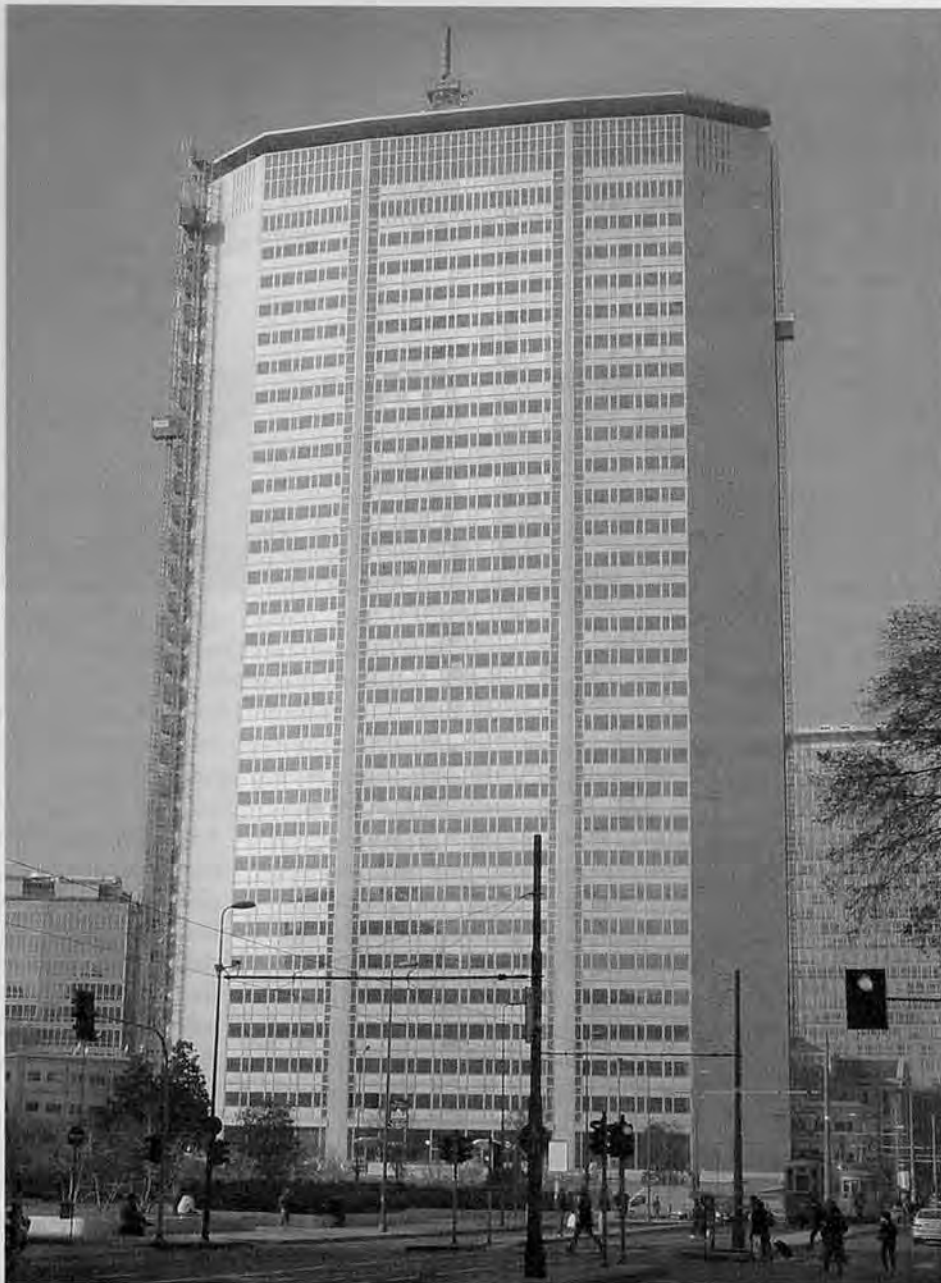
Fig. 1 - Milano, grattacielo Pirelli, la facciata verso piazza Duca d'Aosta dopo l'intervento di restauro; l'edificio è stato risanato, ma non privato delle patine che si sono formate nonostante la giovane età del manufatto.
