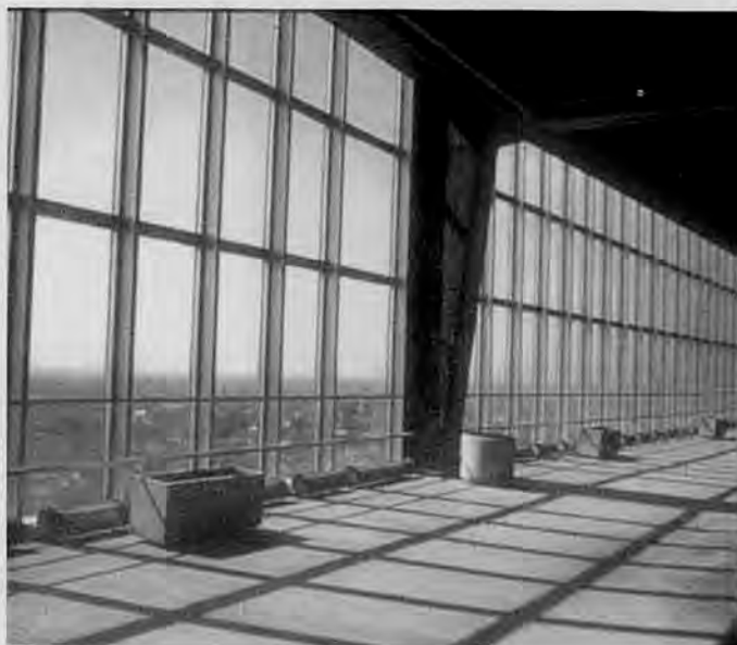
Fig. 2 - Il 31° e ultimo piano dell'edificio nel 1999; il grande spazio è caratterizzato da una struttura in cemento armato faccia a vista con nervature in evidenza ed è chiuso da vetrate a tutt'altezza. Si notino gli apparecchi illuminanti collocati a terra in corrispondenza di ciascuna campata per illuminare l'edificio e restituirne la 'forma finita' anche nelle ore notturne.
