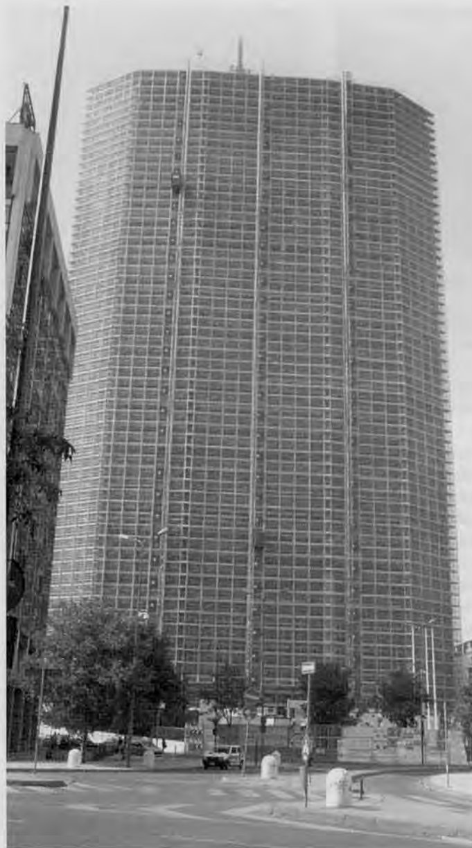
Fig. 6 - Il grattacielo avvolto nei ponteggi durante i lavori di restauro delle facciate (febbraio 2003); oltre agli ascensori in corrispondenza delle 'punte', ne sono stati montati altri tre su ciascuna facciata per agevolare la movimentazione dei materiali durante le operazioni di smontaggio e rimontaggio dei pannelli curtain wall.
