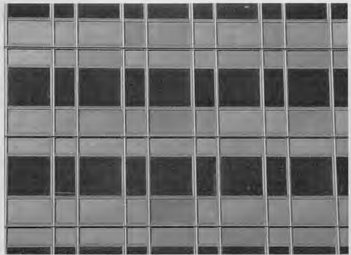
Fig. 10 - Particolare dei pannelli curtain wall dopo l'intervento di restauro; le superfici hanno riacquisito unitarietà e omogeneità senza risultare chiassosamente nuove.
