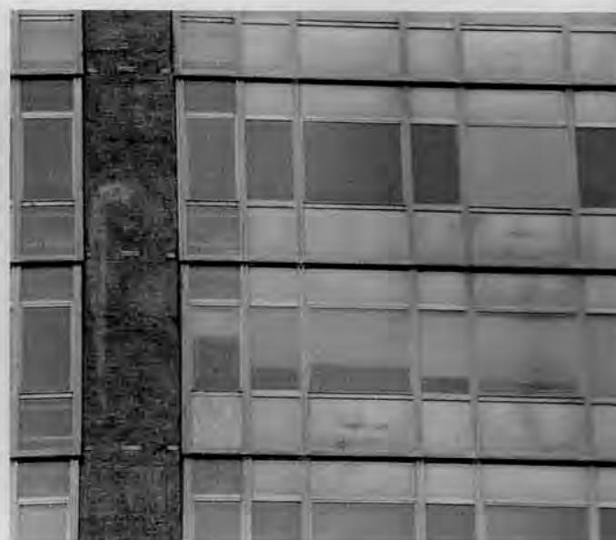
Fig. 3 - Dettaglio della facciata prima dell'intervento di restauro; sulle facciate continue si notano varie forme di degrado, quali depositi superficiali sui profilati metallici, danni ai pannelli spandrel, decolorazione delle vetrate trasparenti e il distacco del rivestimento in tessere di ceramica dai pilastri in calcestruzzo armato.
