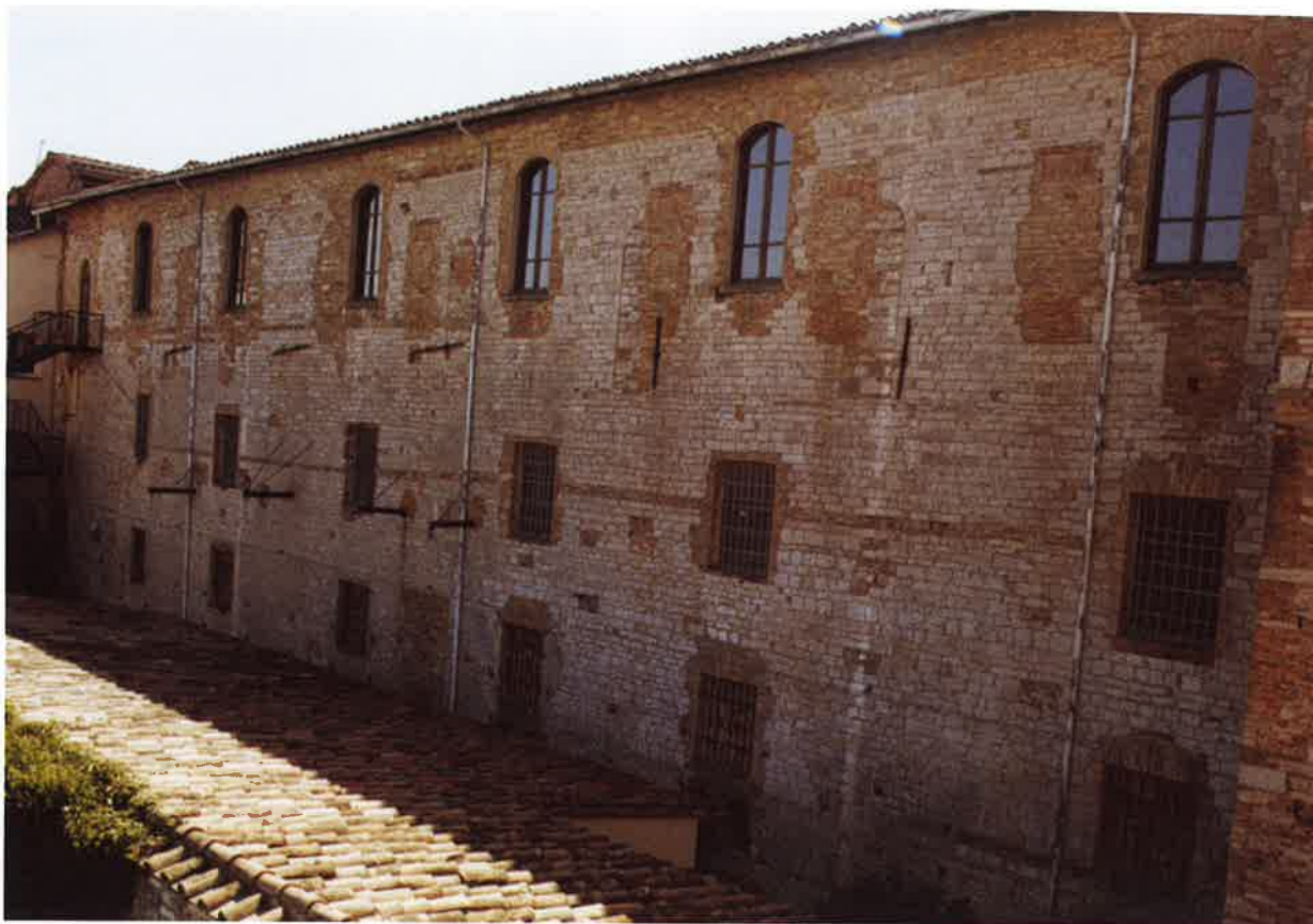
Fig. 5. Vista del prospetto nord della chiesa di S. Domenico 'vecchio'; si notano numerose finestre aperte in breccia nel paramento murario in blocchetti di calcare rosa e bianco e quelle che illuminavano la chiesa, di forma allungata e terminanti ad arco, tamponate in seguito alla trasformazione dell'aula in caserma.
