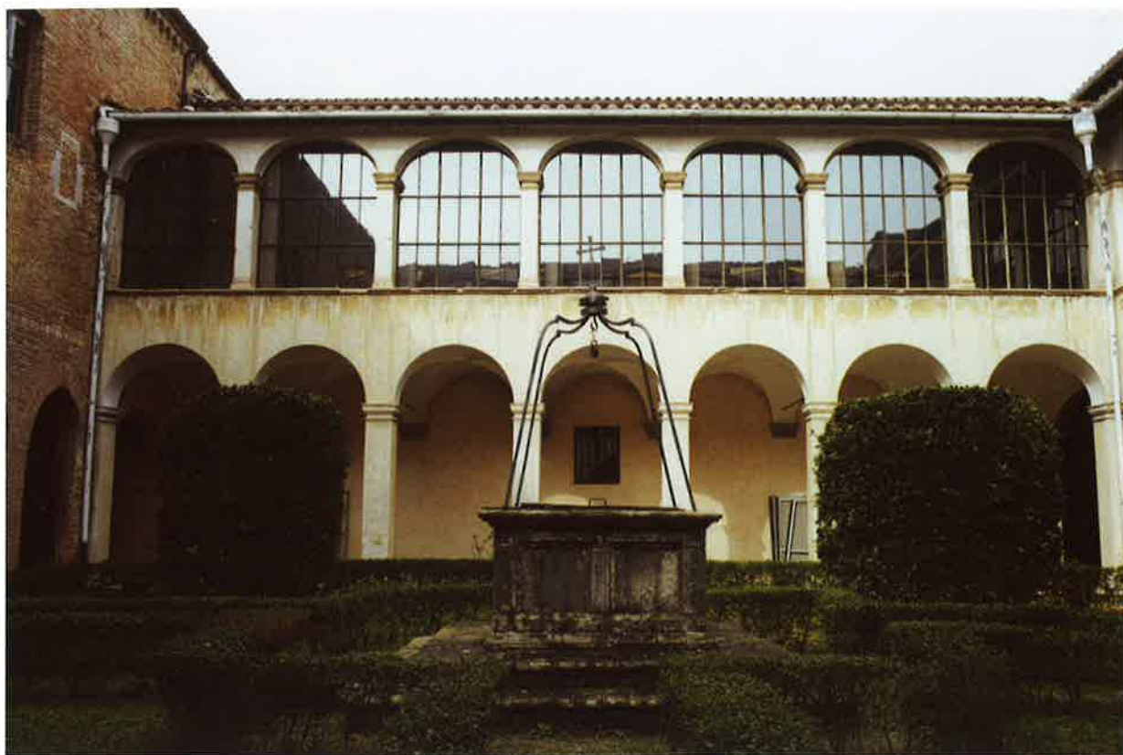
Fig. 40. L'assetto settecentesco del braccio sud-est del chiostro piccolo.
