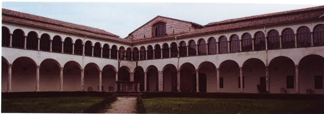
Fig. 24. Vista del chiostro 'grande' verso la chiesa di S. Domenico 'vecchio'; in corrispondenza della facciata della chiesa, il passo delle campate s'accorcia, evidenziando una soluzione di continuità, architettonica e strutturale, fra i due lati del portico.
