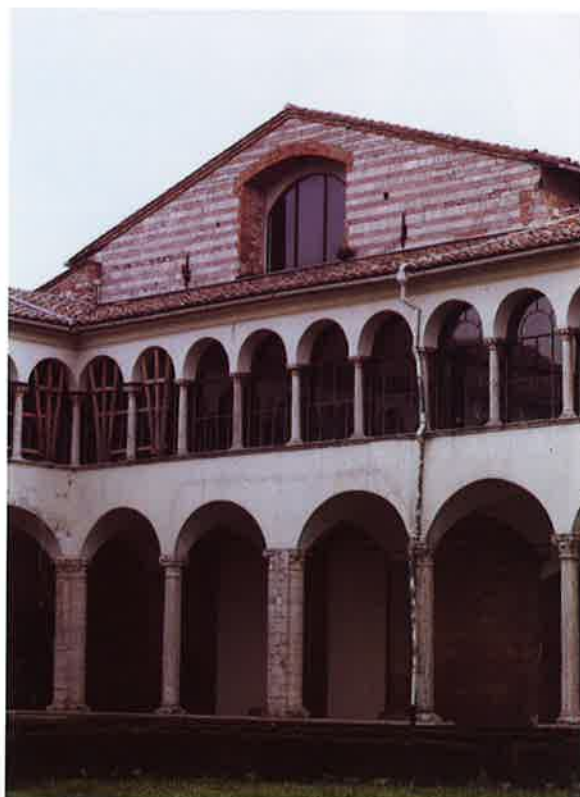
Fig. 25. Dettaglio dell'immagine precedente. Si nota che la serie di colonne a sostegno delle volte del portico è interrotta da due pilastri polilobati, posti sull'angolo ed in asse con lo stipite destro del portale d'ingresso alla chiesa. L'interruzione del ritmo e del tipo di sostegno attesta l'esistenza di una struttura provvisoria costruita per contrastare la volta d'angolo in attesa che fossero completati gli altri bracci del portico.
