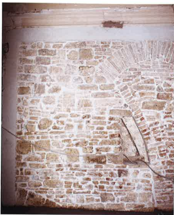
Fig. 31. Il paramento murario che chiude l'abside della chiesa 'vecchia'. Si nota, inglobato nella parete, un tratto di arcone della volta, tornato alla luce durante i lavori di consolidamento e restauro eseguiti negli ambienti dell'Archivio di Stato di Perugia.
