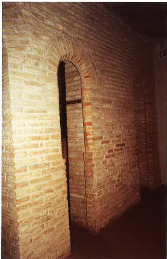
Fig. 33. Dettaglio di una delle finestre che un tempo illuminavano le celle del dormitorio quattrocentesco e successivamente trasformate in porte quando, nel Cinquecento, fu aggiunta una loggia sul fronte sud-ovest della fabbrica; nonostante le modifiche, l'alloggio dell'infilso è ancora ben visibile.
