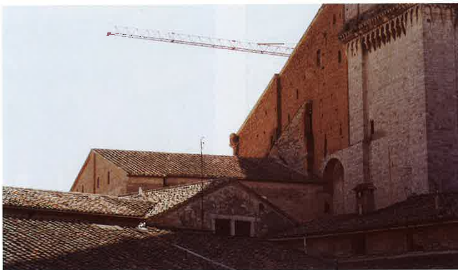
Fig. 22. Vista della finestra a croce che originariamente illuminava la biblioteca; l'apertura si trova oggi esclusa dall'ambiente, soffocata fra i tetti dei corpi di fabbrica adiacenti, notevolmente sopraelevati durante il secolo scorso.
