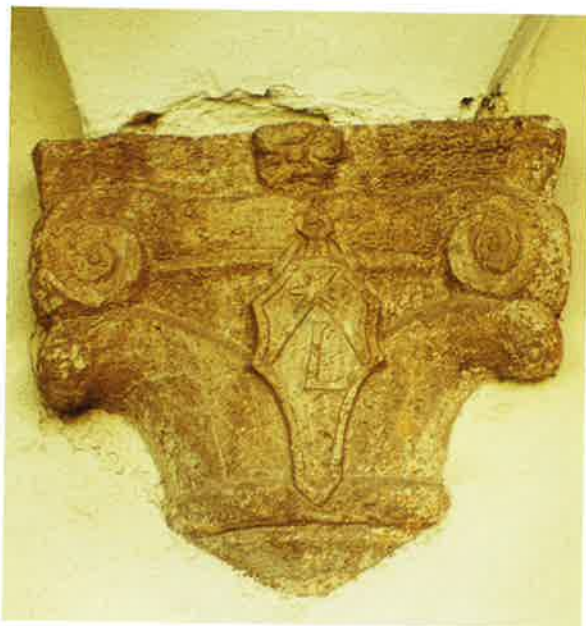
Fig. 34. Peduccio della volta del braccio sud-ovest del chiostro 'grande' costruito nel Quattrocento.
