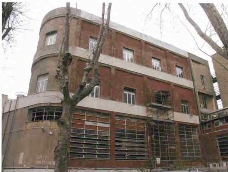
FIGURA 19 • Roma, ex "Casa Gil" a Trastevere. Il corpo di fabbrica che conteneva le palestre all'aperto nello stato odierno. Il restauro attualmente in corso ha consentito di ritrovare l'apertura ad andamento curvo, che illuminava in testata l'ambiente al primo livello, rimasta inglobata all'interno della tamponatura più tarda. Essa conserva ancora l'infisso metallico originale in buone condizioni.
