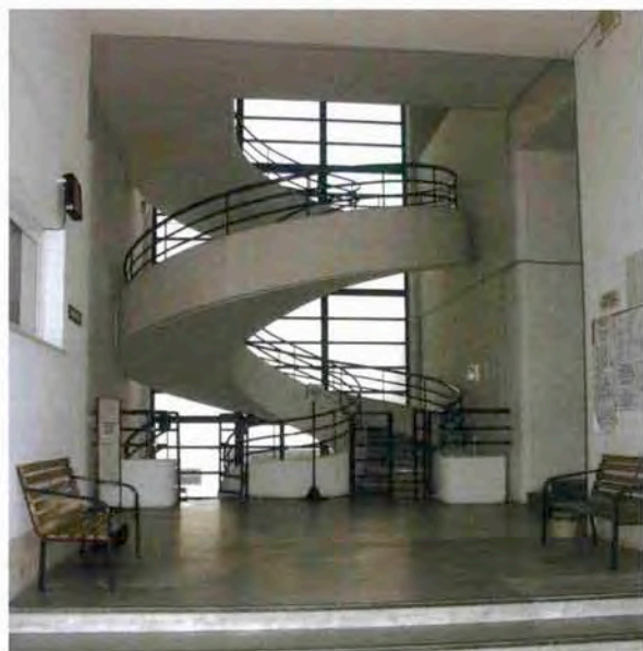
FIGURA 5 • Roma, ex "Casa Gil" a Trastevere. La scala elicoidale che distribuisce gli spazi per aule, ambulatori e palestre accessibili da via Ascianghi in un'immagine attuale.
