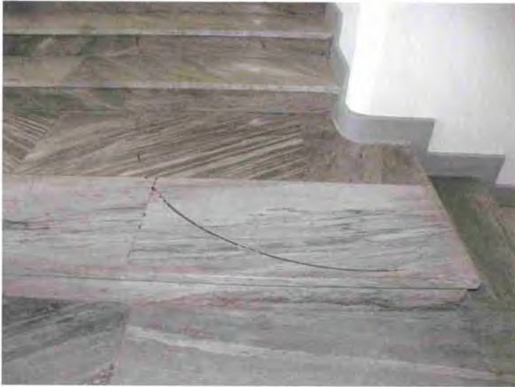
FIGURA 28 • Roma, ex "Casa Gil" a Trastevere. Dettaglio delle piccole risarciture effettuate per integrare le lacune della pavimentazione, in lastre di marmo bardiglio, causate dall'impropria destinazione d'uso dell'edificio. Con l'intervento di restauro si è preferito conservare e reintegrare, piuttosto che rinnovare, le lastre danneggiate, poiché si trattava di rivestimenti autentici ricchi di valenze testimoniali ed estetiche; inoltre, per quanto le zone degradate attestassero un periodo di decadenza dell'opera, la scelta conservativa effettuata sta ad esprimere il voluto rispetto dei segni apportati dal tempo sulle vecchie superfici.
