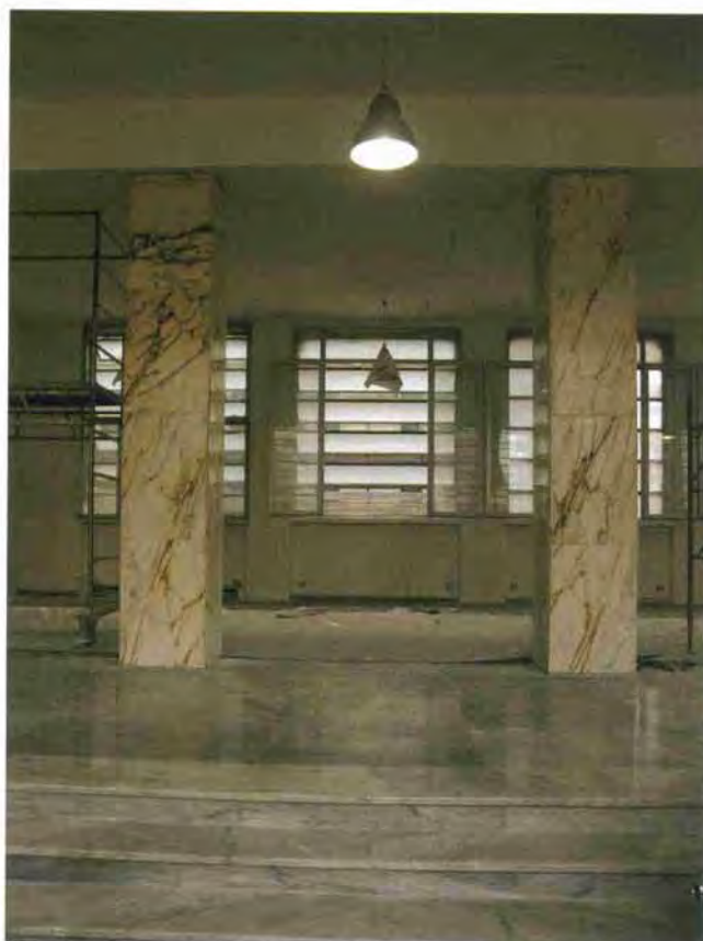
FIGURA 30 • Roma, ex "Casa Gil" a Trastevere. Il "salone degli onori" durante l'intervento di restauro. La rimozione delle tamponature tra i pilastri ha finalmente consentito di recuperare la continuità spaziale e la permeabilità alla luce e all'aria con cui Moretti caratterizzò questo magnifico ambiente.
