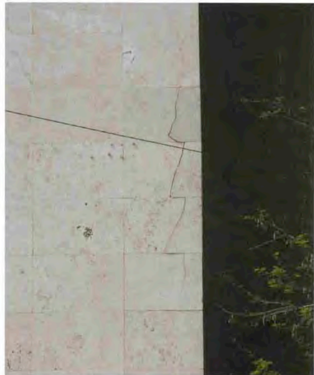
FIGURA 27 • Roma, ex "Casa Gil" a Trastevere. a) Grafico del progetto esecutivo di Luigi Moretti per la realizzazione del rivestimento, in lastre di travertino, del prospetto verso largo Asciani della torre dell'arengo; si notino la cura e il disegno dettagliato delle varie lastre che costituiscono il rivestimento. b) Dettaglio dello spigolo destro del rivestimento, con le lastre fratturate in seguito a un intervento errato di riadesione mediante grappe metalliche (Storelli, 2007).
