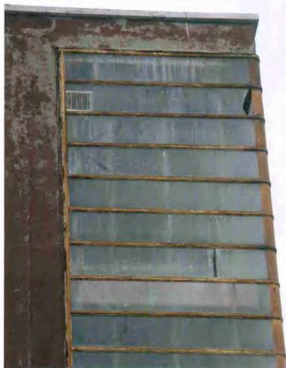
FIGURA 13 • Roma, ex "Casa Gil" a Trastevere. Dettaglio della vetrata che avvolge l'angolo della torre dell'arengo fra piazza Ascianghi e via Induno; infissi e vetrate originali sono stati sostituiti operando pesanti modifiche fra cui il non trascurabile posizionamento di un montante in corrispondenza dello spigolo esterno, in origine del tutto trasparente.
