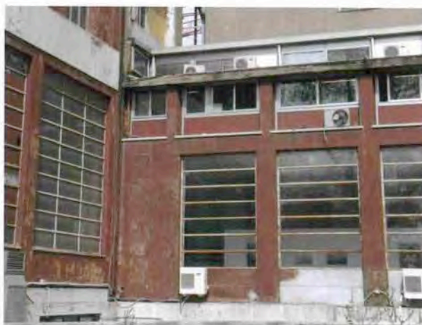
FIGURA 20 • Roma, ex "Casa Gil" a Trastevere. Dettaglio del prospetto esterno delle grandi vetrate che illuminano a tutt'altezza la "galleria degli onori"; si nota la tamponatura della fascia bassa delle aperture, risalente alla seconda metà degli scorsi anni Novanta. L'aggiunta, tuttavia, non ha comportato la perdita dell'infisso metallico rimasto inglobato all'interno della muratura e ancora ben visibile.
