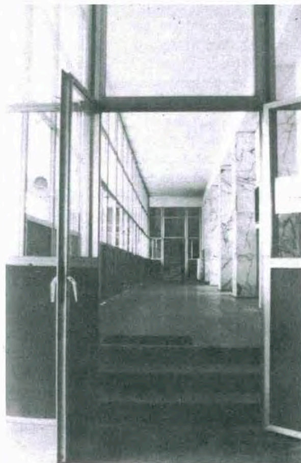
FIGURA 8 • Roma, ex "Casa Gil" a Trastevere. a) e c) L'assetto della galleria e b) del "salone degli onori" prima della rimozione delle aggiunte operate nella seconda metà degli scorsi anni Novanta (da Finelli, 1989).
