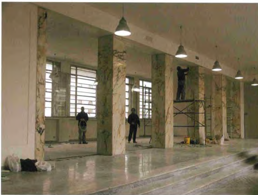
FIGURA 29 • Roma, ex "Casa Gil" a Trastevere. L'ex "salone degli onori" dopo la rimozione delle tamponature tra i pilastri che, aggiunte nel secondo dopoguerra, per decenni avevano offuscato la bellezza di questo luminoso ambiente.
