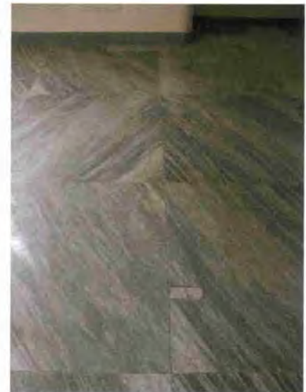
FIGURA 28 • Roma, ex "Casa Gil" a Trastevere. Dettaglio delle piccole risarciture effettuate per integrare le lacune della pavimentazione, in lastre di marmo bardiglio, causate dall'impropria destinazione d'uso dell'edificio. Con l'intervento di restauro si è preferito conservare e reintegrare, piuttosto che rinnovare, le lastre danneggiate, poiché si trattava di rivestimenti autentici ricchi di valenze testimoniali ed estetiche; inoltre, per quanto le zone degradate attestassero un periodo di decadenza dell'opera, la scelta conservativa effettuata sta ad esprimere il voluto rispetto dei segni apportati dal tempo sulle vecchie superfici.
